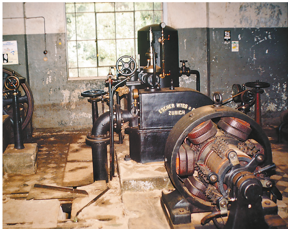
↑ SALA DE MÁQUINAS DE LA CENTRAL HIDROELÉCTRICA (ARCHIVO MUSEO HISTÓRICO DE PLACILLA).
