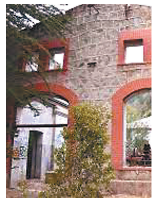
↑ RUINAS DE LA ANTIGUA CENTRAL HIDROELÉCTRICA EL SAUCE.
