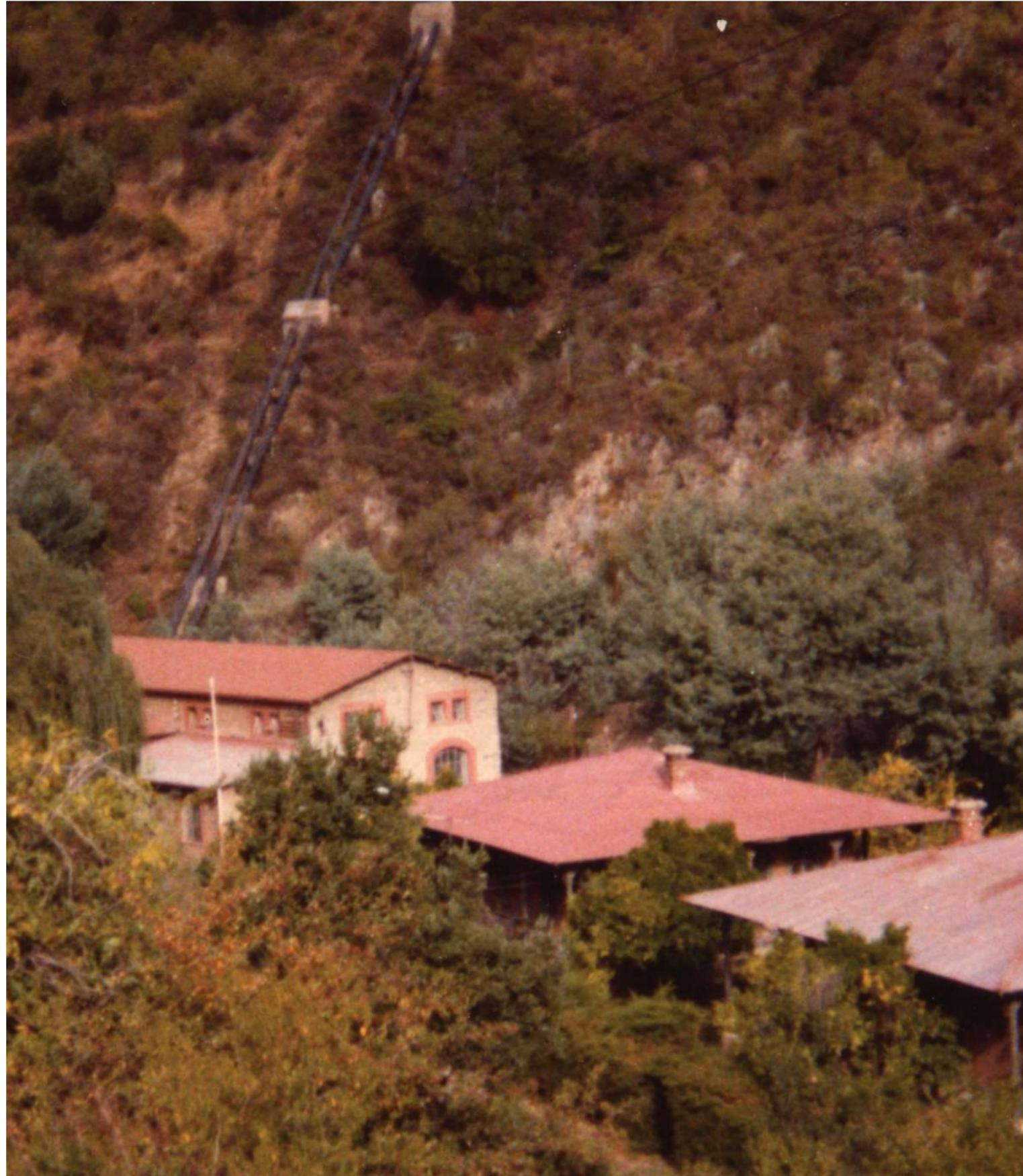
Sobre el funcionamiento de la central relató Luis: “El agua que hacía mover las turbinas venía de lo que es el tranque La Luz. Eso venía por un túnel, dos torres de captación [...], y bajo tierra venían las aguas, llegaban a una cámara de carga y de ahí venían dos tuberías que bajan [...] hasta la central, en aproximadamente 500 metros de línea, y eso hacía mover las turbinas. Luego, la energía se mandaba al sistema, a la red de alta tensión”.
