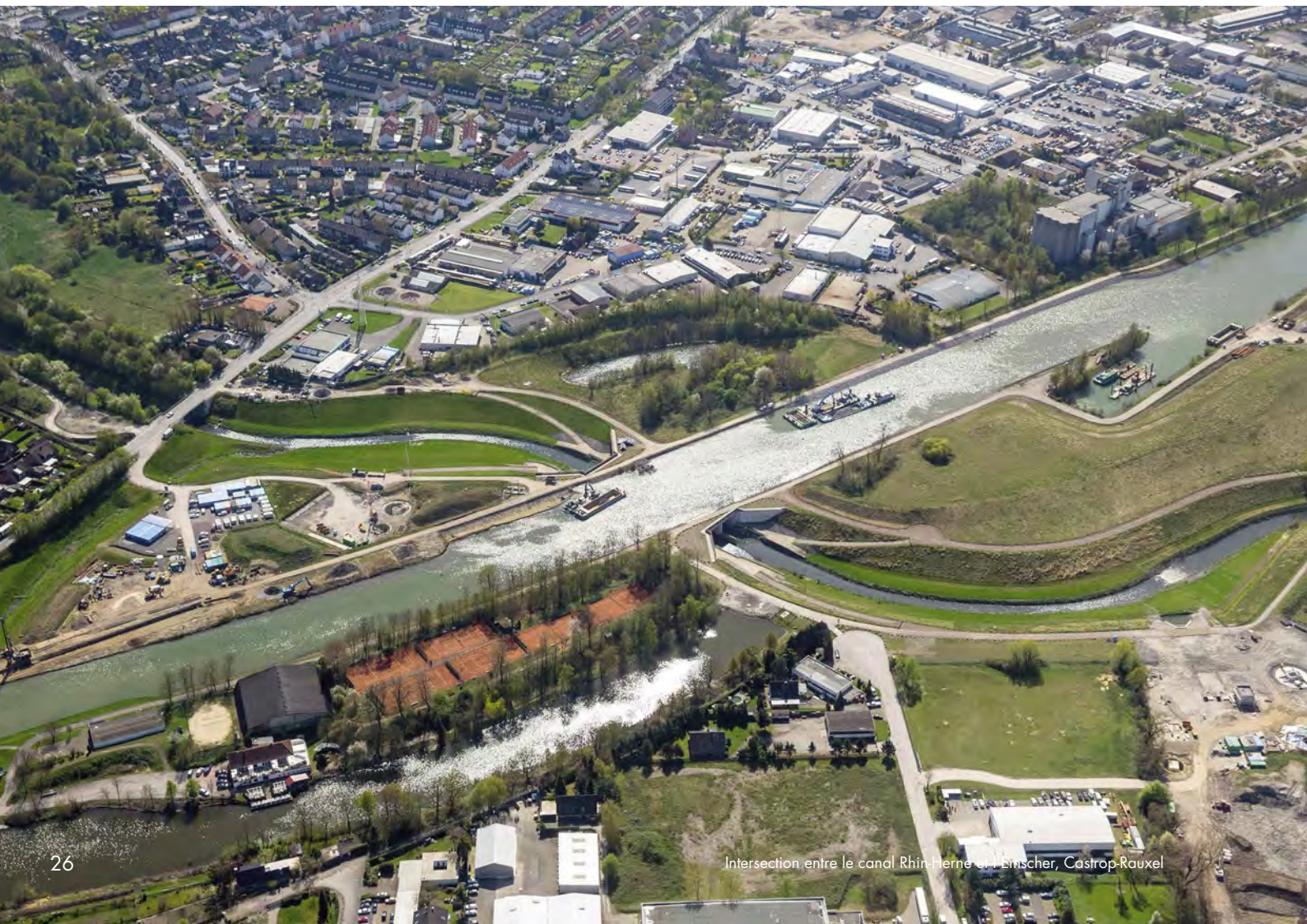
Station d'épuration Bernemündung, Bottrop-Ebel
