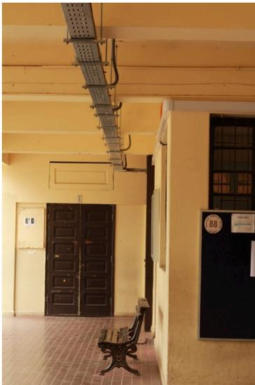
**Figura 7.8.33: Contraste del nuevo sistema eléctrico con la vieja infraestructura**
